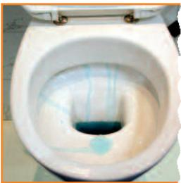
Wasser läuft unbemerkt: Der Wasserhahn rinnt, die Dichtung des Spülkastens ist porös – das geht auf Dauer ins Geld.
